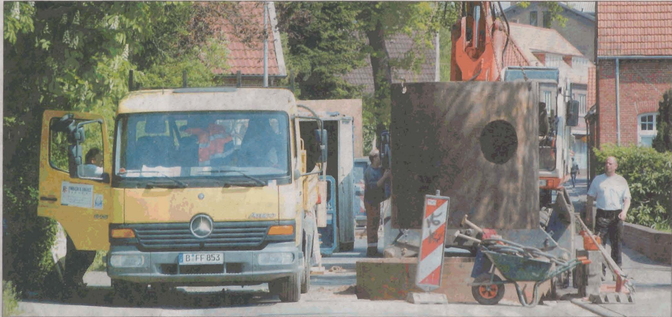
Unter den Eisenbahnschienen hindurch wird derzeit an der Süderstraße eine neue Kanalleitung verlegt.
