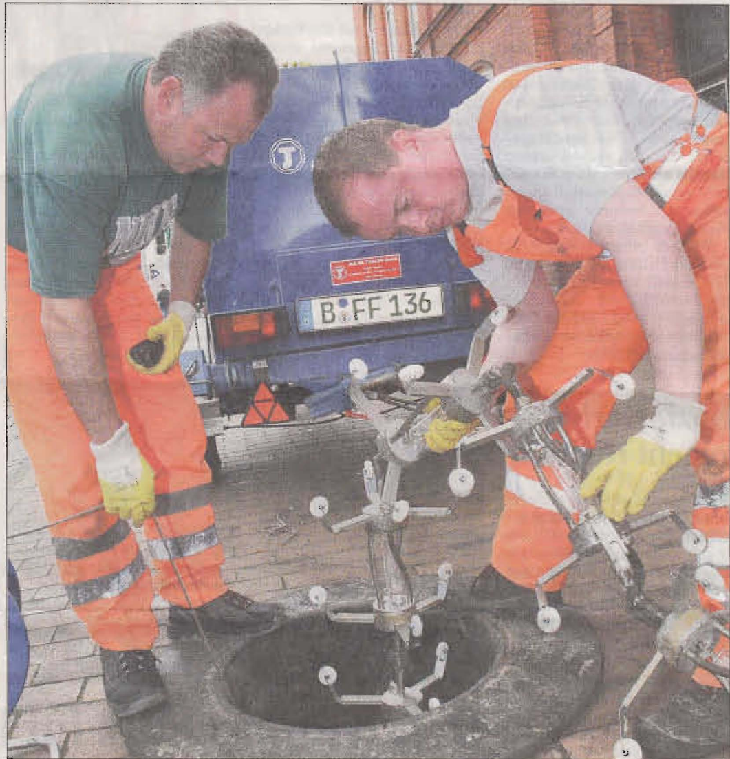
Olaf Meier (links) und Jörg Steinhagen sind auf Baustellen in ganz Europa unterwegs. Gestern arbeiteten sie am Rendsburger Schlossplatz. Foto Wagner
